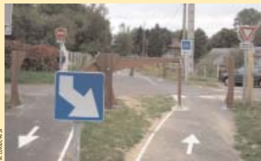
9- Îlot central pour séparation et déport des flux sur voie verte (VV) souligné de marquage blanc ; VV comportant semi-barrière pivotante, potelet amovible en bordure d'îlot et panneau Cédez-le-passage (cf. cas 2 et 4 et illustration 13)
