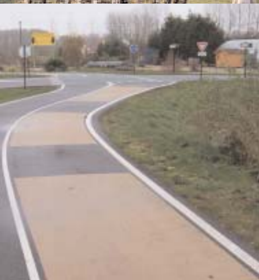
5- Marquage d'alerte et virage sur véloroute (VR) avant l'arrivée à l'intersection avec régime Cédez-le-passage pour la VR (cf. cas n° 4)
