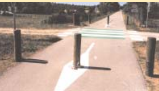
14- Cas n° 3: voie verte prioritaire par rapport à un chemin de terre équipé d'un panneau Cédez-le-passage
