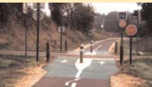
13- Cas n° 2: route à faible trafic restant prioritaire par rapport à la VV sur laquelle le STOP a été préféré au régime Cédez-le-passage par manque de visibilité; la règle reste le régime Cédez-le-passage (cf. illustration 9)
