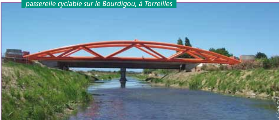
passerelle cyclable sur le Bourdigou, à Torrelles
