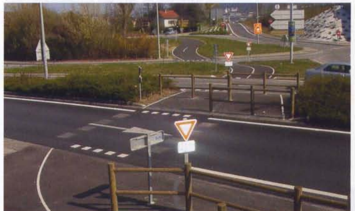
RN réaménagée pour sécuriser la voie verte (CETE Lyon)
