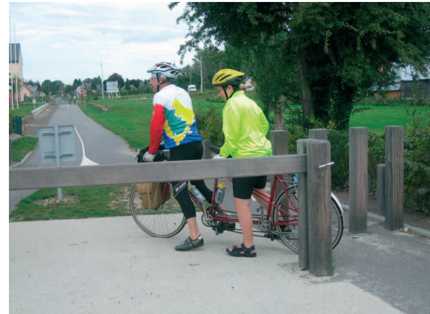
▲ Les chicanes peuvent constituer une interdiction de passage pour les tandems, les remorques et les PMR
