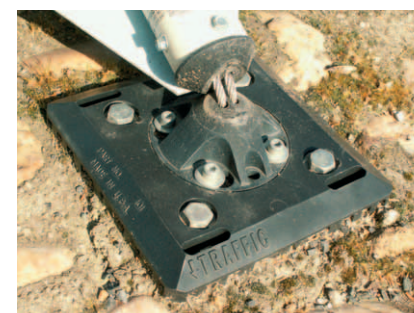
▲ Un potelet basculant est muni d'un ressort interne
