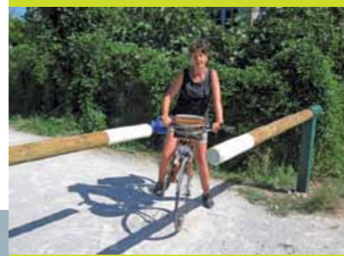
Ces demi-barrières sont simples et efficaces, mais trop serrées : diminuées d'un mètre environ, elles répondraient parfaitement aux besoins
