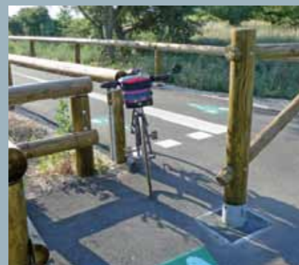
Cette chicane ralentit les cyclistes sans empêcher le passage des remorques.
