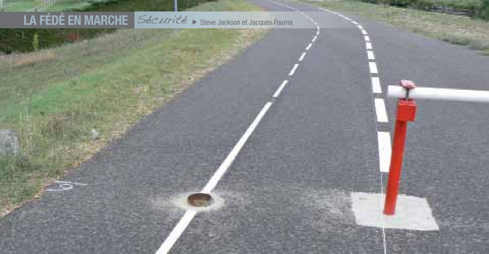
Le pire exemple que nous connaissons : une voie verte très fréquentée où tous les poteaux sont placés au milieu de la trajectoire des cyclistes. Ceci est très dangereux en groupe
