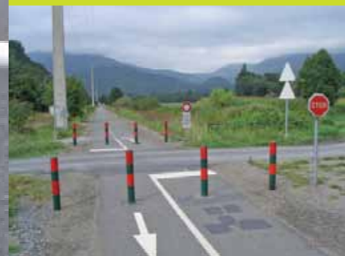
Le pire exemple que nous connaissons : une voie verte très fréquentée où tous les poteaux sont placés au milieu de la trajectoire des cyclistes. Ceci est très dangereux en groupe
