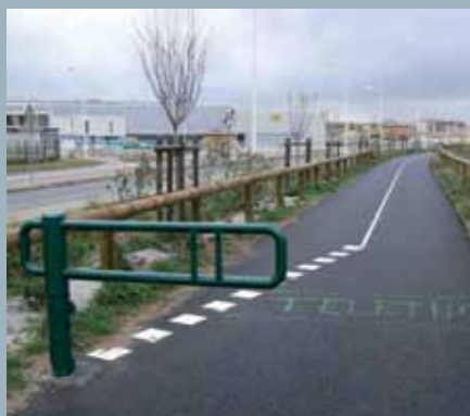
Une demi-barrière avec marquage au sol : un bon accès pour tous les usagers et un mobilier bien arrondi.
