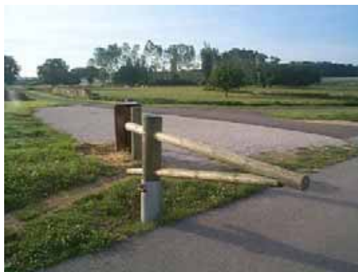
Photo 7 : Barrière en porte à faux sur la Voie Verte de Givry à Cluny
