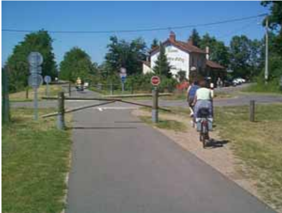
Photo 4 : les cyclistes contournent les chicanes trop contraignantes (Voie Verte de Givry à Cluny)
