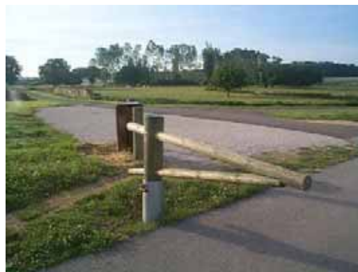
Photo 7 : Barrière en porte à faux sur la Voie Verte de Givry à Cluny
