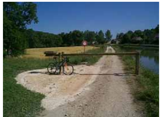
Photo 6 : Barrière basculante sur le Canal de Bourgogne, avec passage sur le côté
