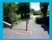
Les chicanes: Distance entre deux barrières: 3 mètres (sinon les cyclistes les contournent sur le côté de la voie). Système si possible pivotant ou coulissant
